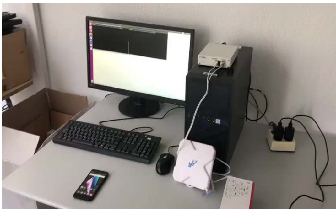
Figura 2. Aspecto del puesto de trabajo para los alumnos, con el nodo de red 4G en funcionamiento.
