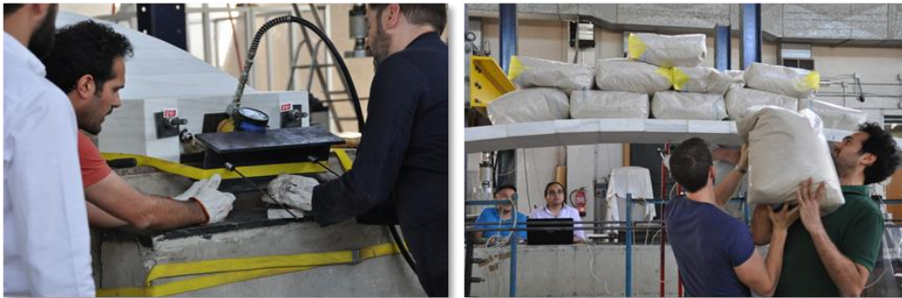
Figura 2. Proceso constructivo y ensayos.
