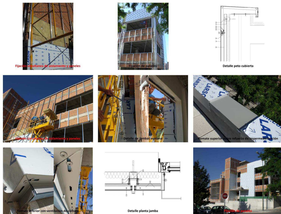
Fig. 1 Fotogramas de video de fachada ventilada de paneles composite de aluminio. Fuente: Elaboración propia (2017)
