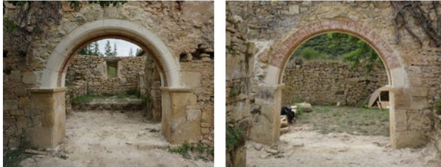
Figura 4. Vistas del arco construido desde el exterior (izda) y desde el interior (dcha)
