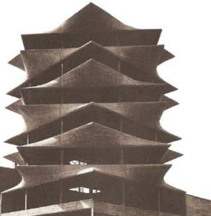
Abstracción geométrica de las superficies regladas (paraboloides hiperbólicos) que componen la volumetría de la edificación.
