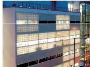
Los grandes logros del panel Kalwall son su baja conductividad térmica y su capacidad de transmitir gran cantidad de luz utilizable con un bajo nivel de transmisión luminosa. Kalwall es un material ligero (habitualmente menos de 15 kg/m<sup>2</sup>), minimizando la necesidad de estructura portante y facilitando su instalación. Además, no requiere un mantenimiento muy intensivo y tiene marcado CE.
